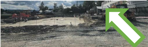
Budynek wielorodzinny ma powstać w ciągu dwóch lat.
