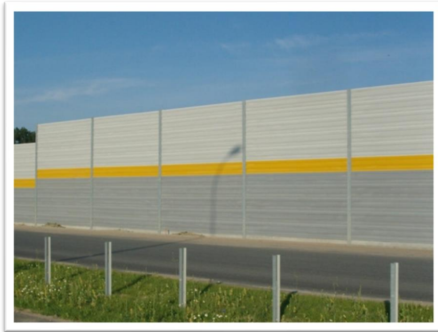
Ekran z paneli metalowych
