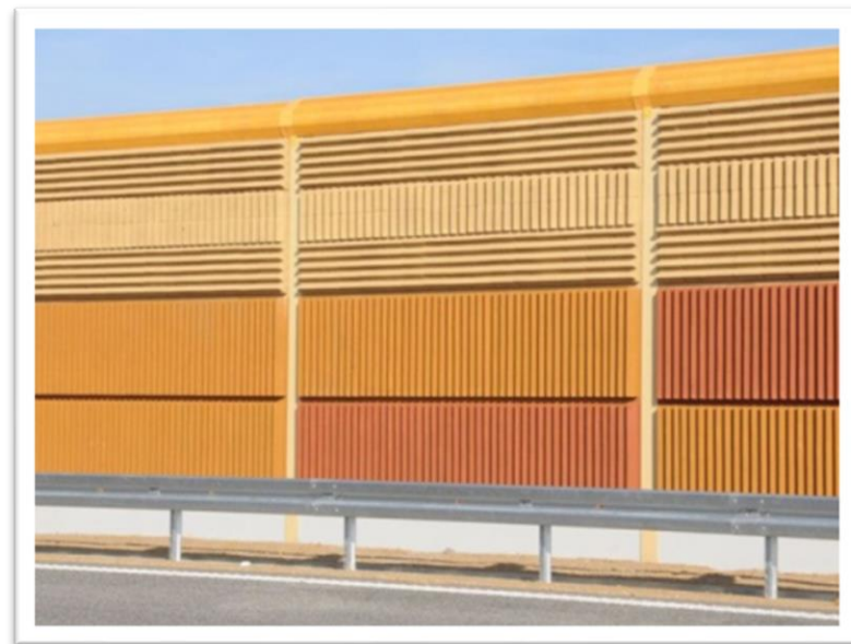
Ekran z okładziną betonową
