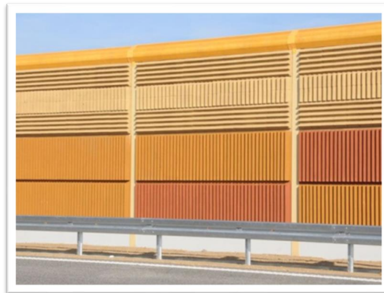
Ekran z okładziną betonową
