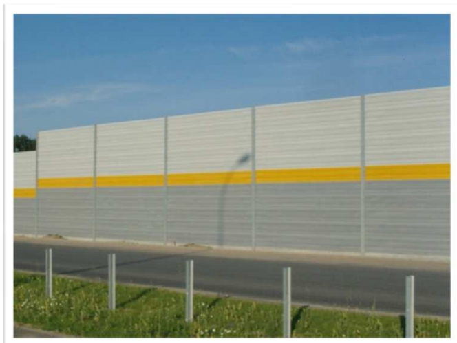
Ekran z paneli metalowych
